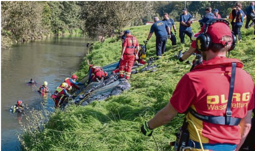
Taucher und Strömungsretter der DLRG sichern den Diemeldamm auf der Wasserseite mit Folien und Sandsäcken.
