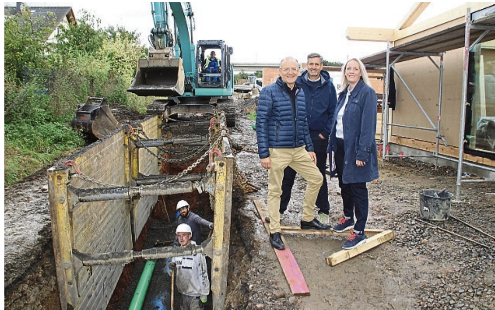
Zufrieden mit den Baufortschritten: Frank Dittmar (von links), Heiko Gringel und Bürgermeisterin Susanne Schneider am Graben der Kanalbauarbeiten für das Neubaugebiet Gänsegarten III. Dort werden 25 neue Bauplätze angeboten. MANFRED SCHAAKE
