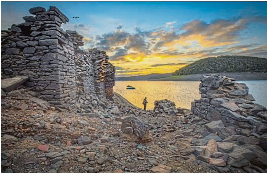
Höchste Zeit, das Edersee-Atlantis zu sichern: Der Zustand der Ruinen, wie im Bild die Reste der Bericher Hütte, hat sich massiv verschlechtert.
