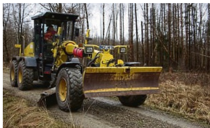
Wenn die Asphaltdecke abgetragen ist, wird ein neuer Schotterweg gebaut. Für das uhrglasartige Wegeprofil sorgt ein Motorgrader von Hessen Forst Technik. ARCHIVFOTO: HESSEN FORST
