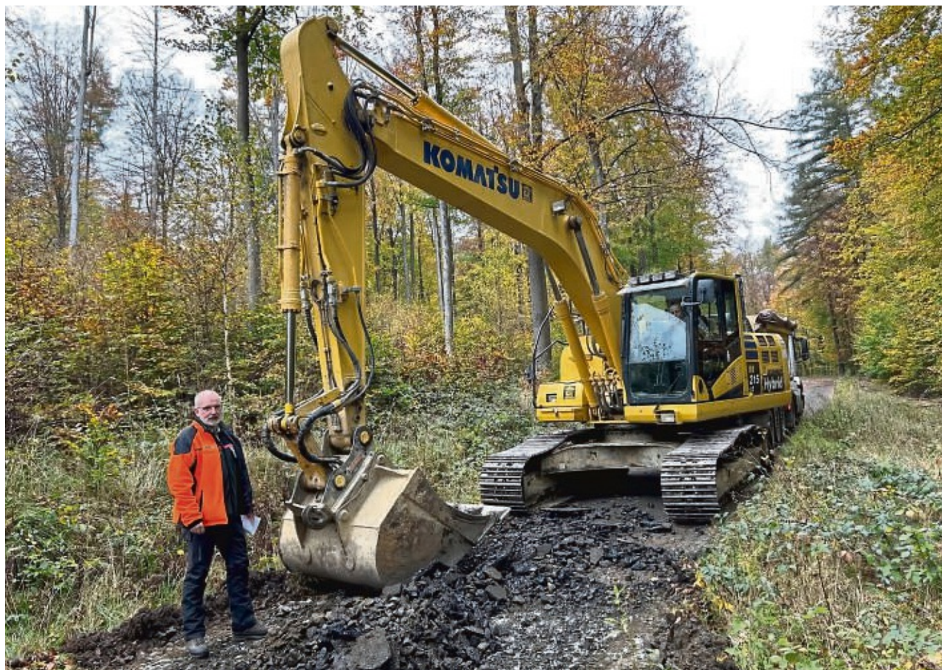
Ein Bagger hebt die PAK-haltige Asphaltdecke ab und hievt sie auf den dahinter stehenden Lkw. In dieser Woche finden die Arbeiten im Revier Wilhelmshausen statt. Forstamtsleiter Holger Pflüger-Grone verfolgte die Arbeiten. FOTO: GERD HENKE
