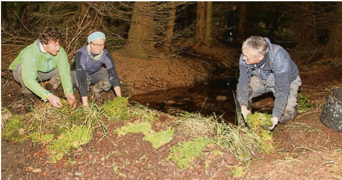
Handarbeit: Die freiwilligen Helfer (von links) Quirin Köppel (München), Kim Hovingh (München) und Gerd Lewin (Hann. Münden) bauen in dem Moor nahe der Sababurg eine Sperre, damit das Wasser im Gebiet bleibt. Dabei setzen sie auch Torfmoos auf die Sperre.
