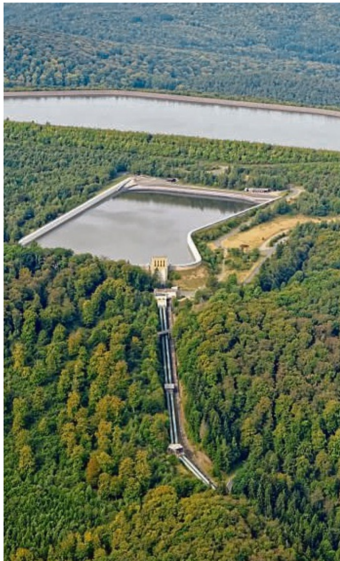
Rohrbahn, Windenhaus und Oberbecken: Auf dem Peterskopf investiert der Kraftwerksbetreiber Uniper fast 50 Millionen Euro in die Verfügbarkeit und Sicherheit der Anlagen des Pumpspeicherkraftwerks Waldeck 1.
