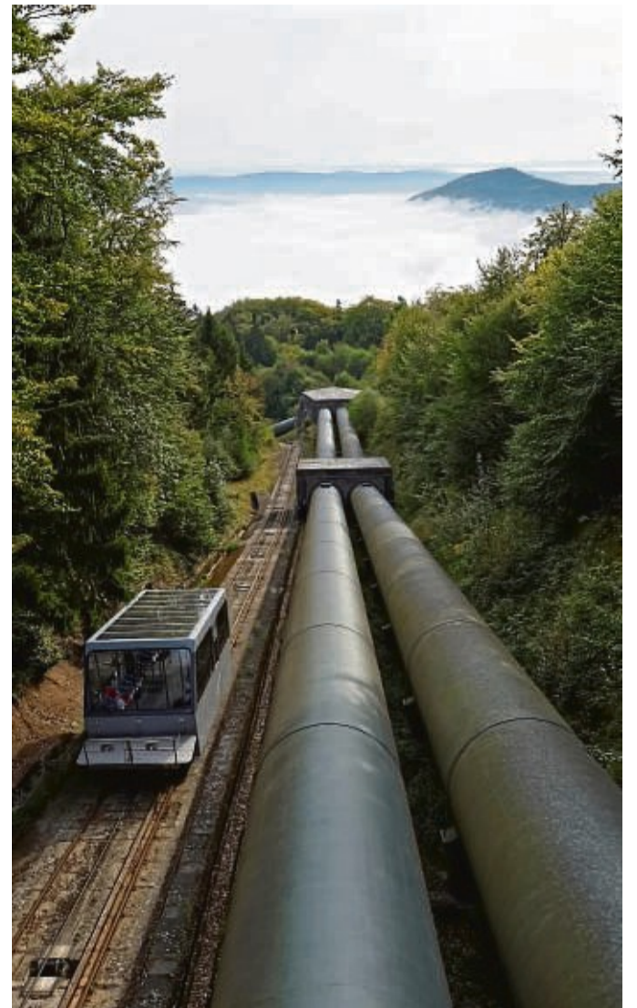
Verbinden Oberbecken mit Maschinenhaus: Die 938 Meter langen Druckrohrleitungen mit einem Durchmesser von 2,5 Metern werden innen mit neuem Korrosionsschutz versehen.
