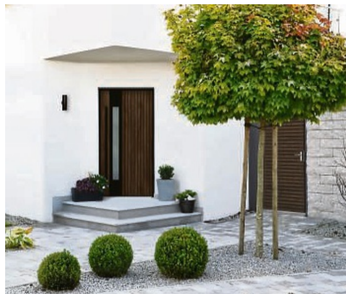
Ein senkrechter Lichtausschnitt lässt Tageslicht in die Wohnung und dient als zentraler Blickfang. Die senkrechte Gestaltung wird von den vertikalen Lisenen wieder aufgenommen. FOTO: RODENBERG
