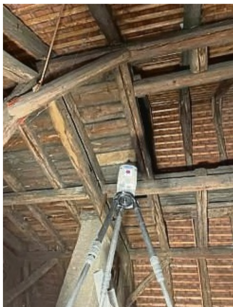
Eine Vermessung am Balkenwerk.
