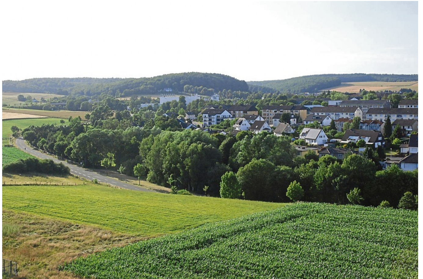
Blick über das Thieletal (im Vordergrund der westliche Bereich) zum Heberg. Die Thiele mit ihrem dichten Baumbestand soll renaturiert, die Aue von Wegen durchzogen werden. FOTOS: ARMIN HASS
