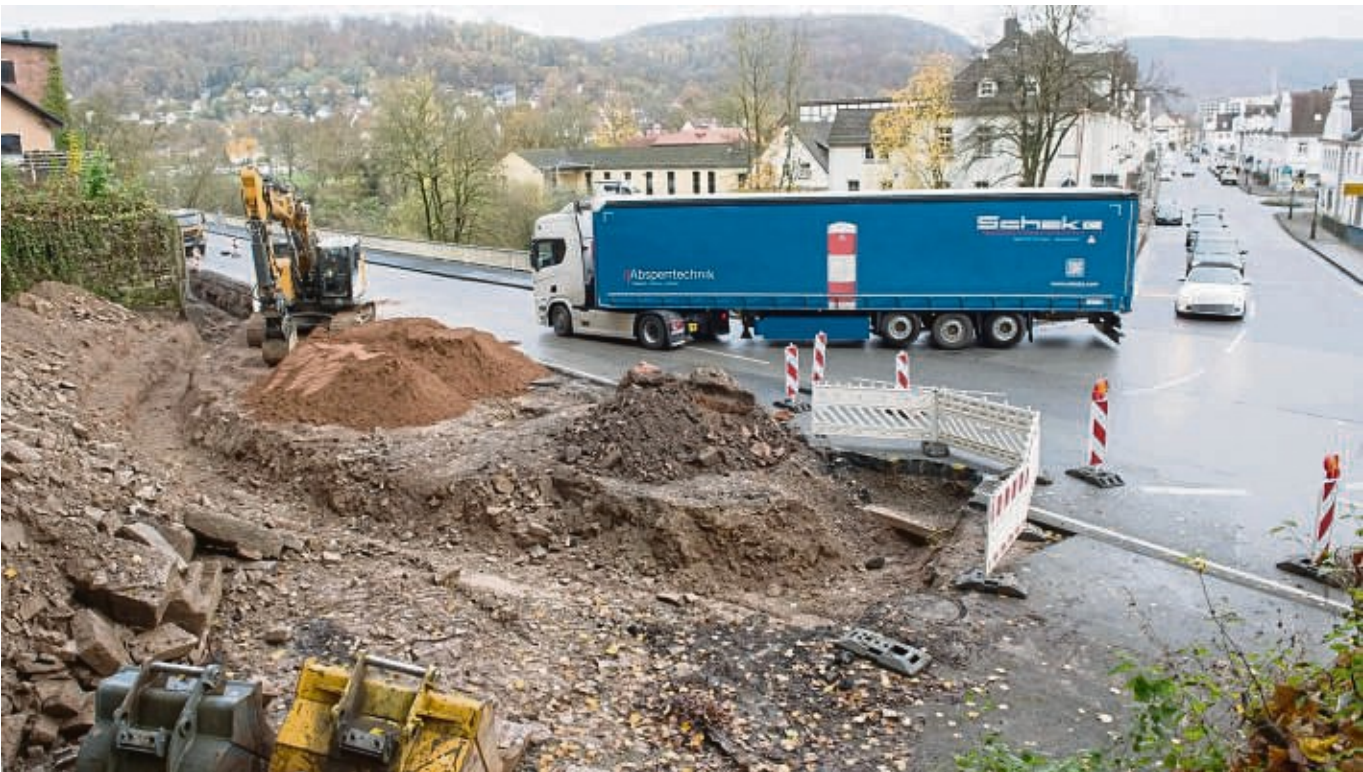
Gefahrenpotenzial: Große LKW schwenken beim Abbiegen in die Gegenfahrbahn. Mit dem Grundstück der ehemaligen „Lionde“ bekommt die Kreuzung nun mehr Platz.
