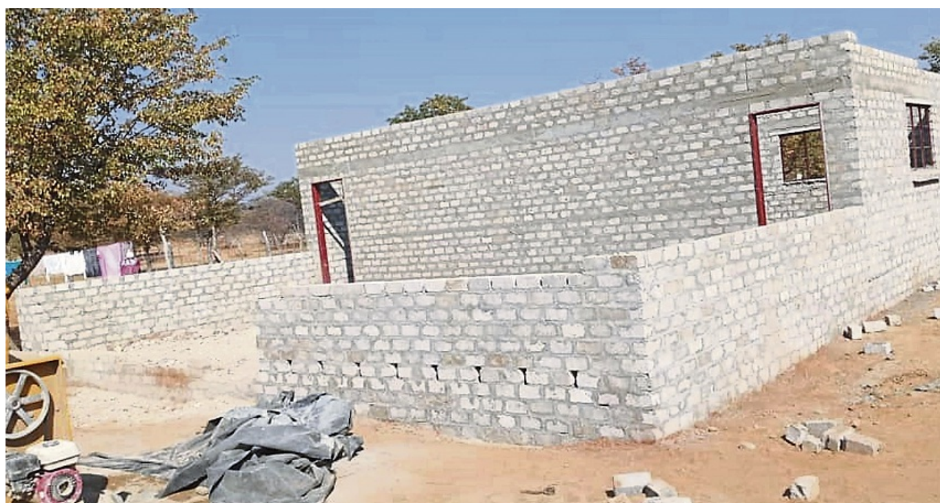
Vorschule Namibia: Mit einem Klassenraum mehr als die Vorschule in Namibia (Foto) soll die Schule in Uganda gebaut werden.
