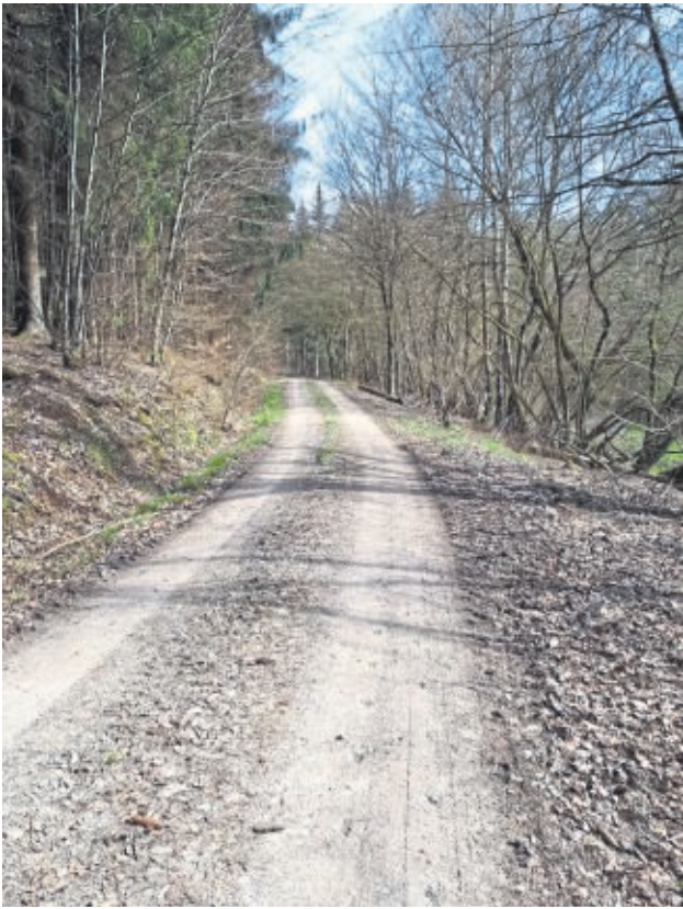
Knüppeldamm unter Schotterdecke. Fundort Abteilung 83 im ehemaligen Forstamt Hersfeld-West, Revier Gittersdorf.
