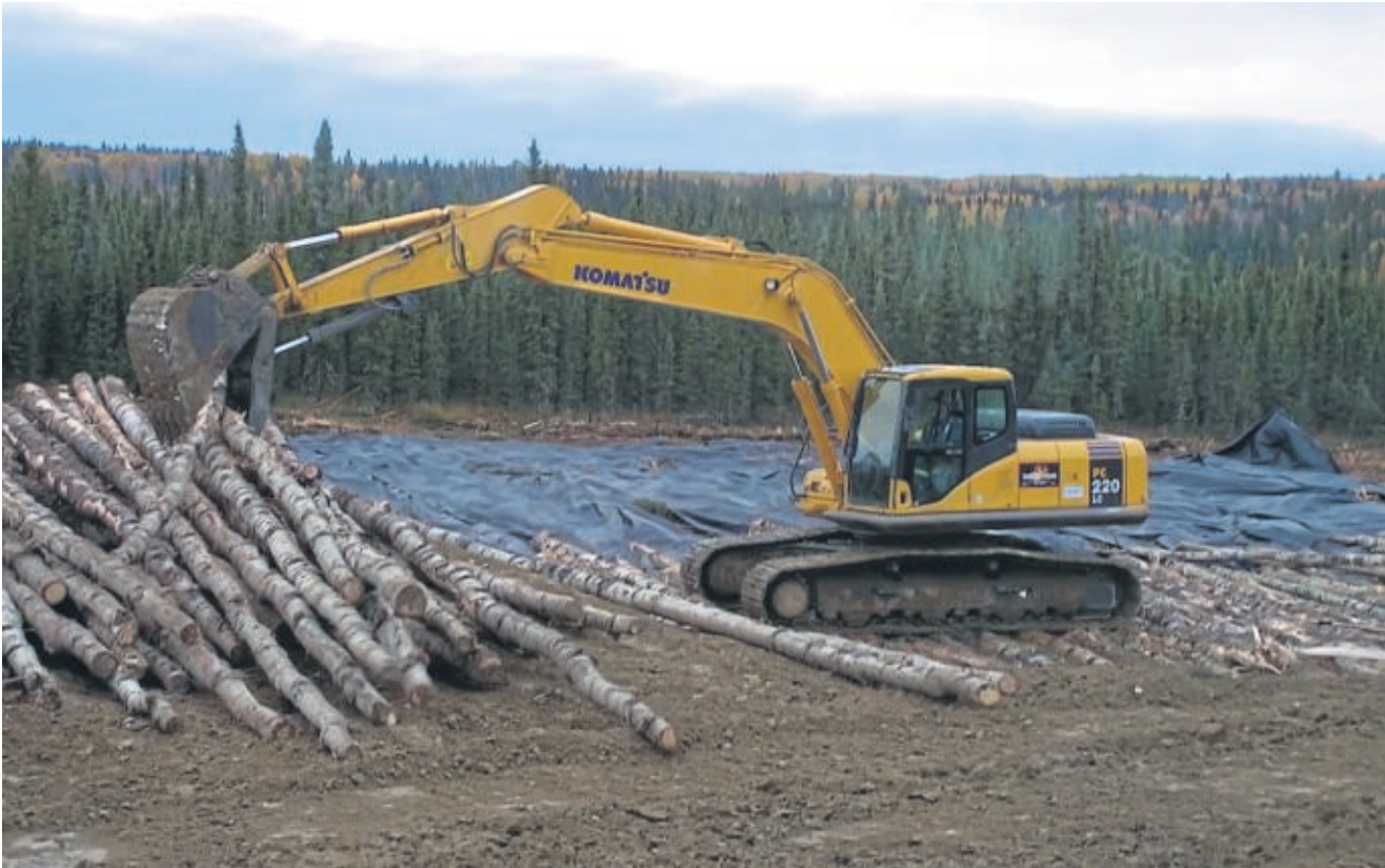
Bau eines Knüppeldammes in heutiger Zeit.
