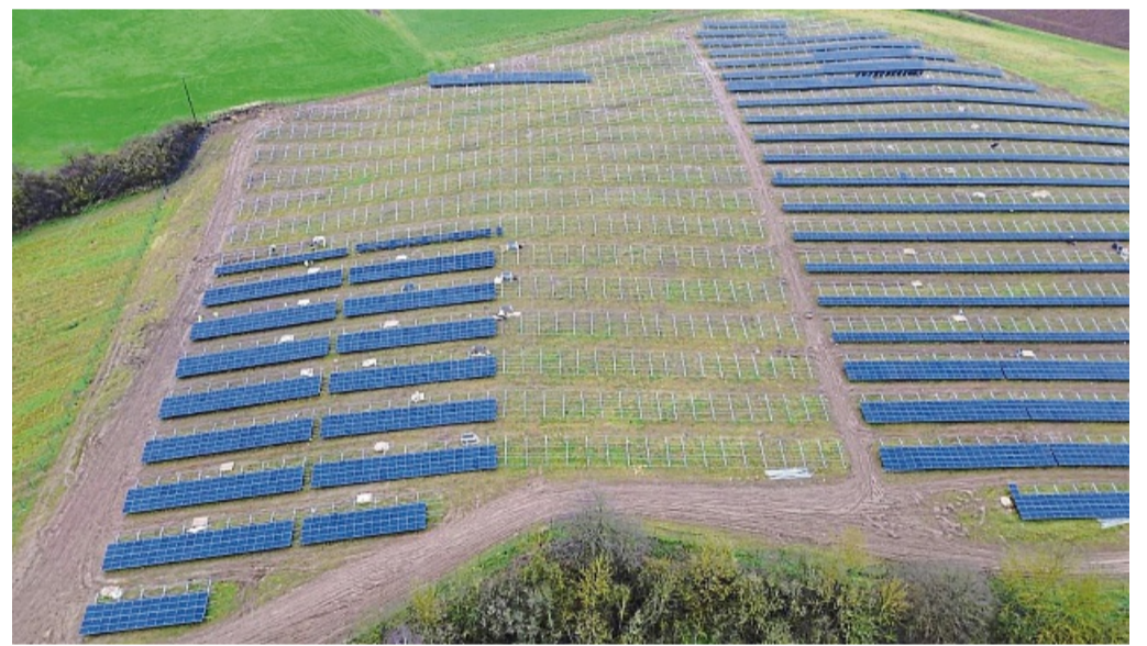
Energie für die Zukunft: In Cornberg entsteht derzeit ein Solarpark mit 8.880 Solarmodulen auf einer rund fünf Hektar großen Fläche.
