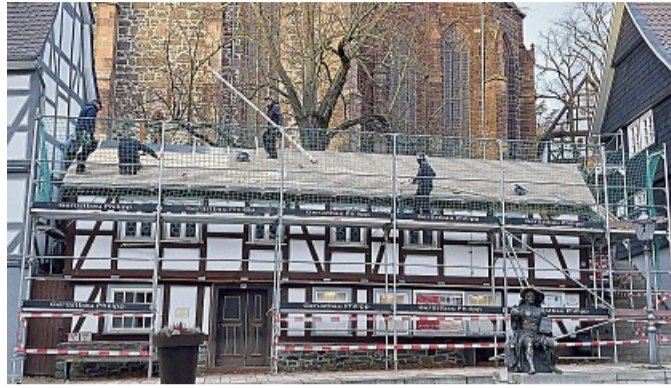
Dachdeckung Möbelwagen in Homberg pünktlich zum Weihnachtenbeginn fertig
