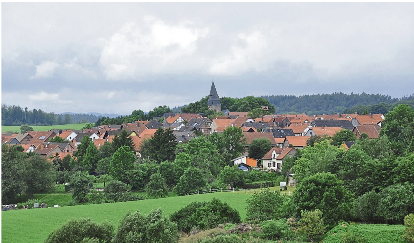
Sanierungshilfe: In historischen Ortskernen, wie etwa in Sachsenberg, sind bereits einige Fachwerkhäuser gekauft und saniert worden – das Förderprogramm soll solche Vorhaben weiterhin unterstützen. ARCHIVFOTO: MARIANNE DÄMMER
