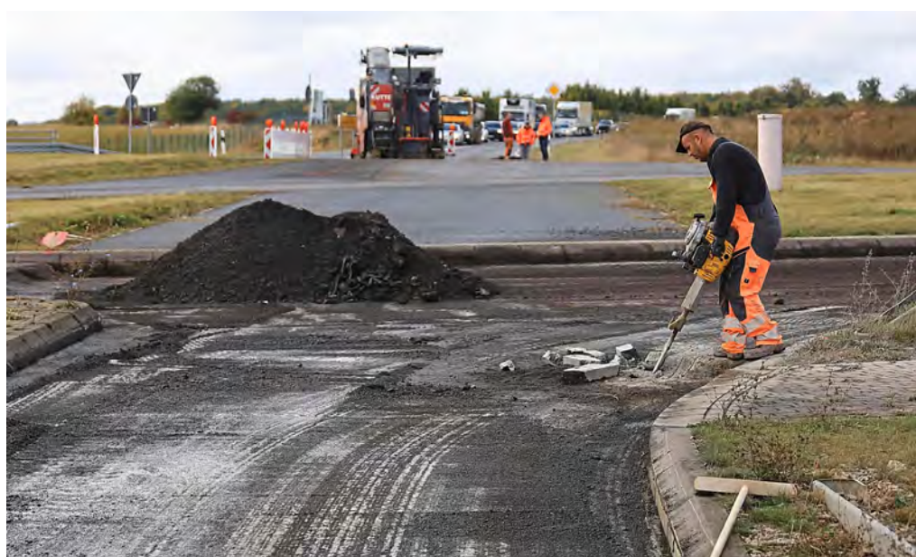
So sah es noch im Oktober aus, als bei Calden am Flughafenkreisel gearbeitet wurde. Die halbseitige Sperrung ist seit Anfang Dezember aufgehoben.
