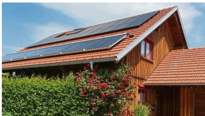
Ein Sonnen-Energiedach mit Solarthermie- und PV-Anlage unterstützt die Wärmepumpe optimal, sorgt für maximale Autarkie und minimale Betriebskosten.
