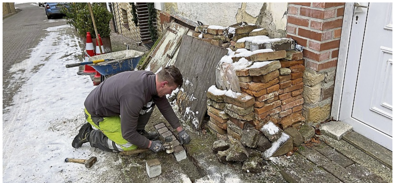
Bei der Arbeit: Alexander Müller vom Bauhof verlegt Stolpersteine vor dem Haus.
