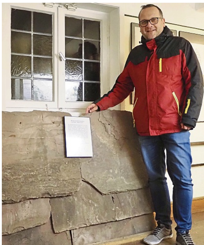
Das Dach von Haus Leck ist mit großen Sandsteinplatten gedeckt, wie sie hier zu sehen sind. Dadurch wiegt es etwa achtzig Tonnen.
