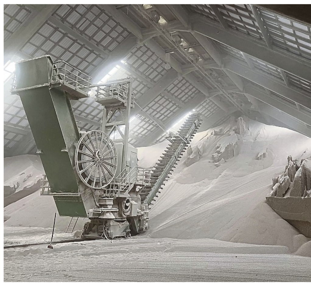
Blick in einen Produktschuppen von K+S: Das gelagerte Korn-Kali wurde zum Teil mit Wärme aus erneuerbaren Energien hergestellt.
