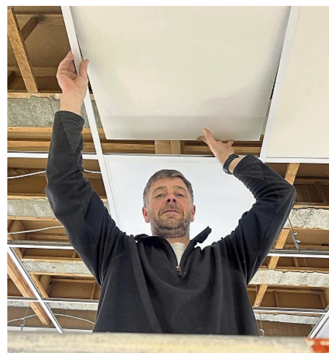
Passt: Andreas Giese, Mitarbeiter des Bauhofs, beim Einlegen der Schallschutzplatten.
