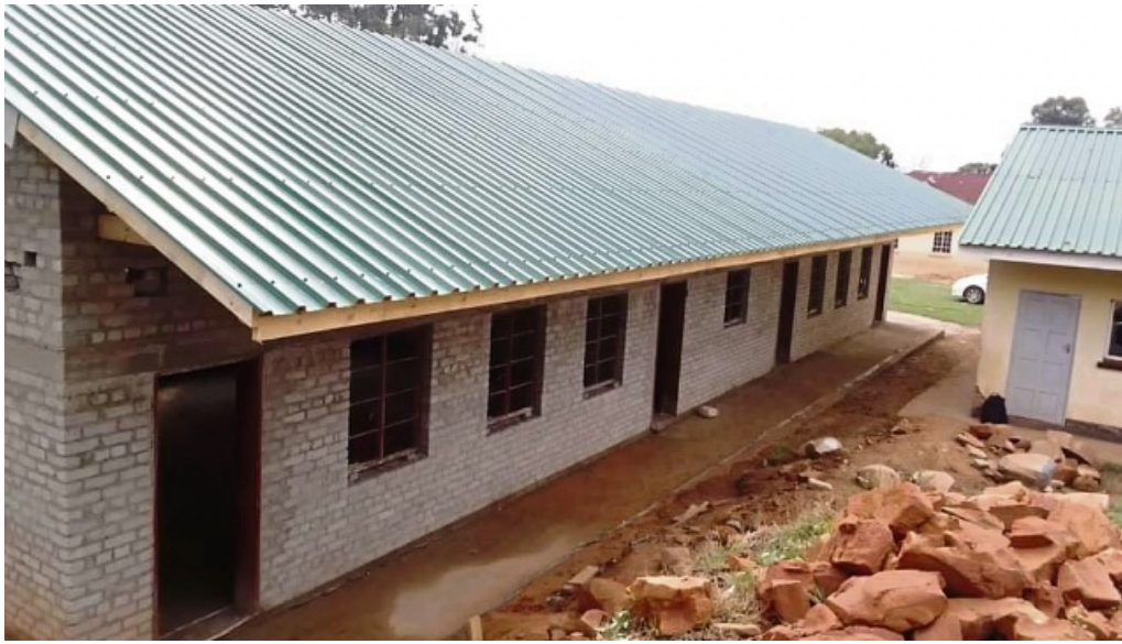
Neubau: Nach und nach wurde der neue Schultrakt gebaut.
