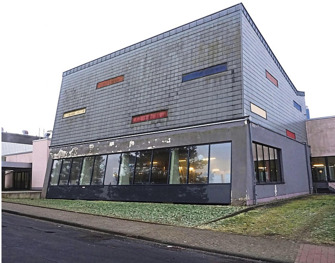
Wird 50 Jahre alt: Welche Arbeiten im Hallenbad anfallen, soll eine Machbarkeitsstudie zeigen.
