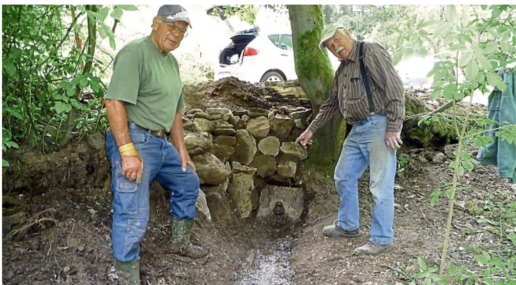
Kümmerten sich ehrenamtlich: Harald Freund (links) und Rainer Krause sanierten 2020 über mehrere Monate einen Quellüberlauf in Hülsa.
