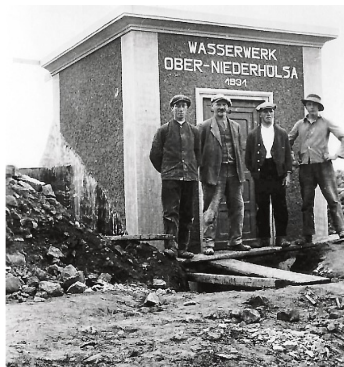
1931 hochmodern, heute noch intakt, aber inaktiv: der Hochbehälter in Hülsa.
