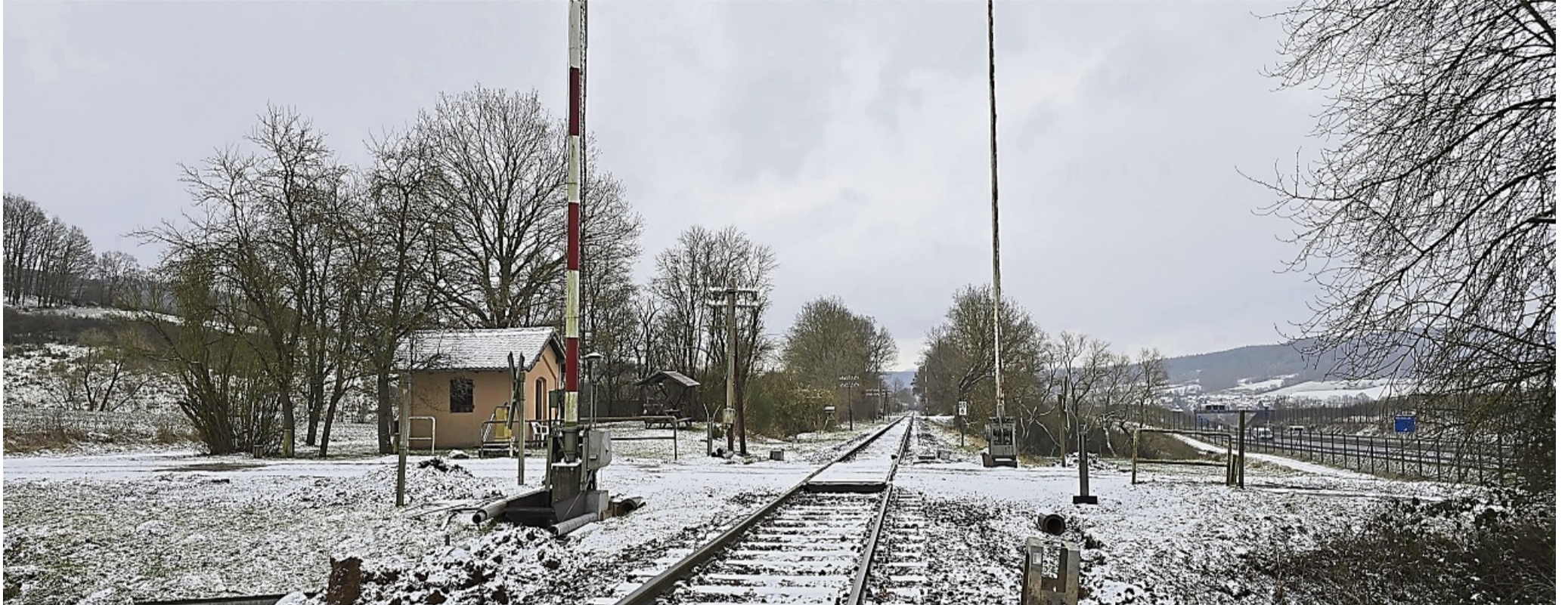
Frisch geschottert und gesichert: der Bahnübergang der Museumsbahn zwischen Bischhausen und Waldkappel.
