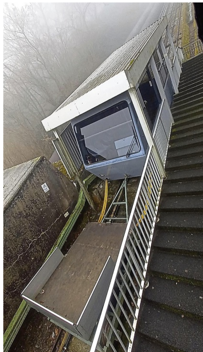
Der Waggon ist schon an den Wagen der Standseilbahn gekuppelt. Bald steht die erste Materialfahrt an. FOTOS: SCHULD
