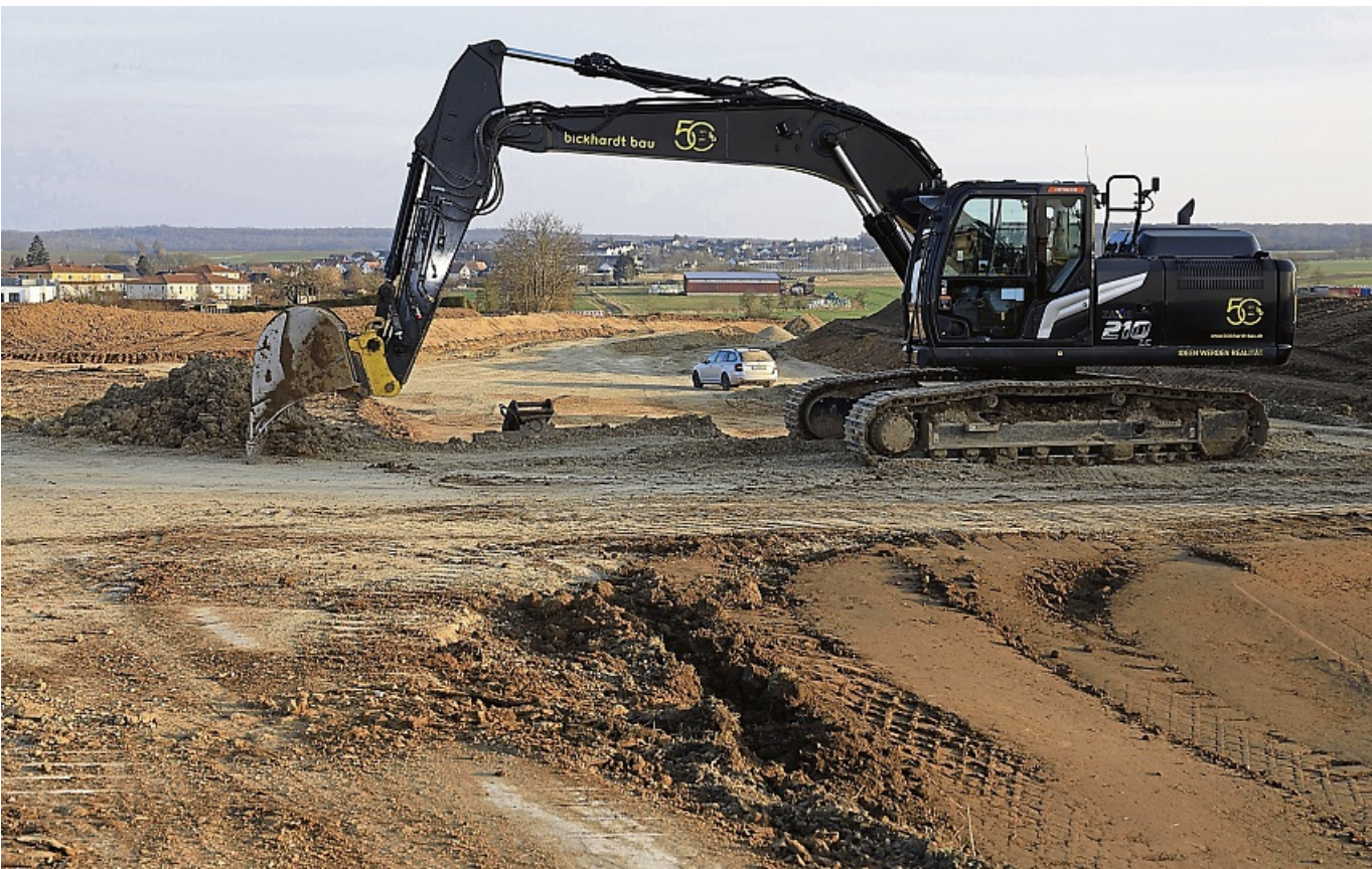
Die neue Trasse der Landesstraße nach Ehrsten ist bereits planiert und in der Landschaft sichtbar.
