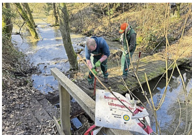
Die Holzbrücke am Lippoldshäuser Wasserfall wurde kürzlich demontiert.
