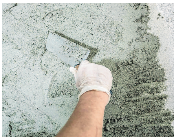
Der Hybridputz ist gebrauchsfertig und wird per Kelle oder Traufe aufgetragen.
