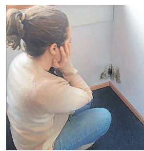
Schreckmoment: Wenn Feuchtigkeit aus dem Erdreich in der Wand hochsteigt, bilden sich an den feuchten Stellen schnell Stockflecken.
