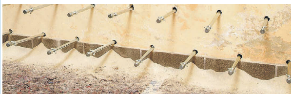
Kellerabdichtung durch Injektion
