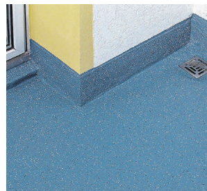
Balkonabdichtung mit Flüssigkunststoff
