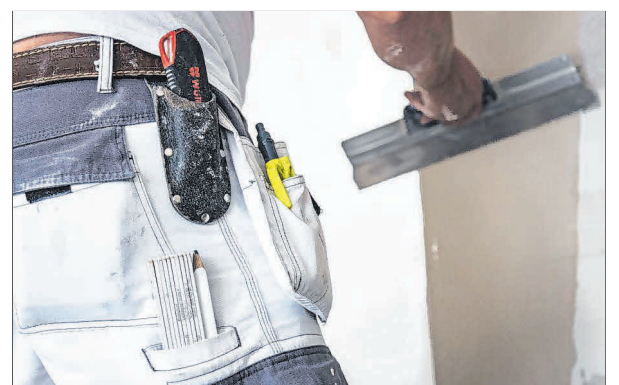
Mehr Neubau, mehr Sanierungen im Kreis Höxter: Der Wohnungsbau muss ein Schwerpunkt bei den schwarz-roten Koalitionsverhandlungen in Berlin sein, fordert die IG BAU Ostwestfalen-Lippe.
