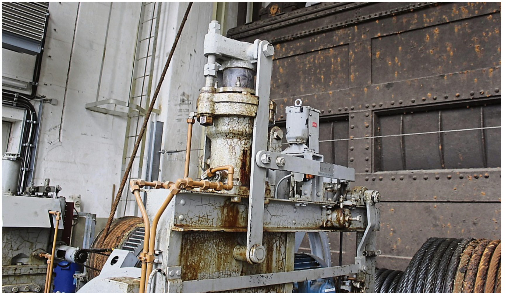
Fast 100 Jahre alte Technik: Die Fallschützen bewahren seit dem Bau des Pumpspeicherkraftwerks den Rest der Technik vor Schaden. Als Denkmal werden sie nun gesichert und erhalten. FOTO: JAKOB BÜCHSENSCHÜTZ
