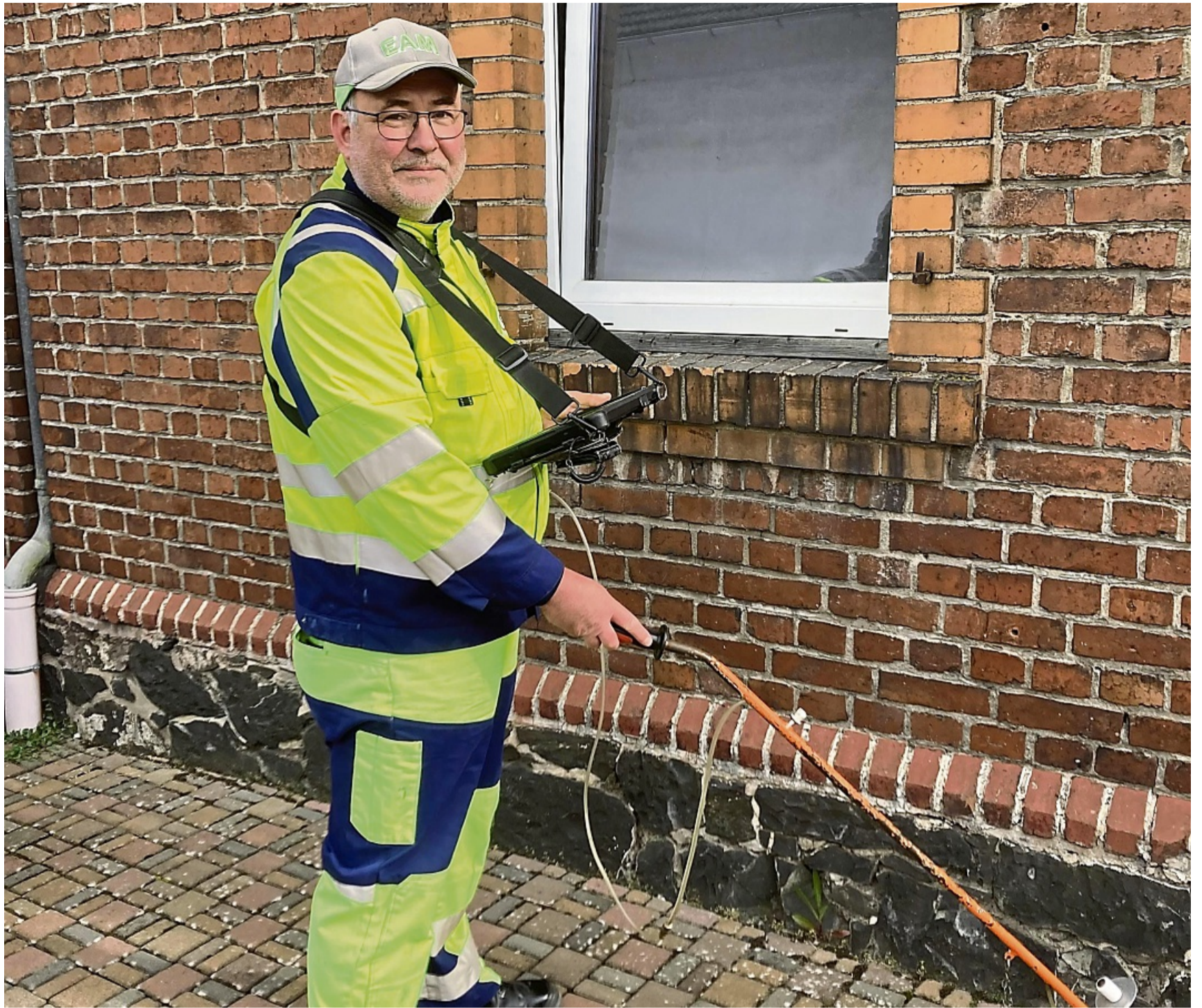
In Hessisch Lichtenau überprüft jetzt ein von der EAM beauftragter Gasspürer (das Foto zeigt Carsten Hahne) die unterirdisch verlegten Gasleitungen auf Dichtigkeit. FOTO: EAM
