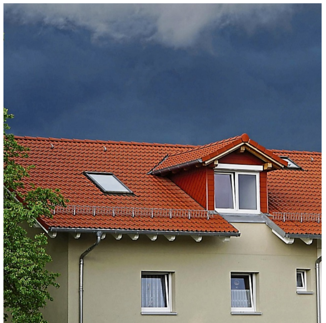
Bei der Planung und dem Bau eines neuen Eigenheims sollte man an Schutz und Sicherheit bei Starkregen oder Hitzewellen denken. DJD/BAUHERREN-SCHUTZBUND/GETTY IMAGES/LIUDMILA KIERMEIER
