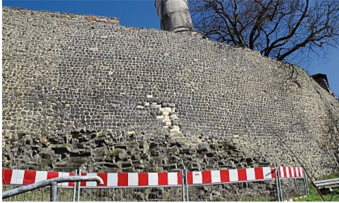
Hier wird gearbeitet: An der Südmauer werden Risse beseitigt. FOTOS: MANFRED SCHAAKE
