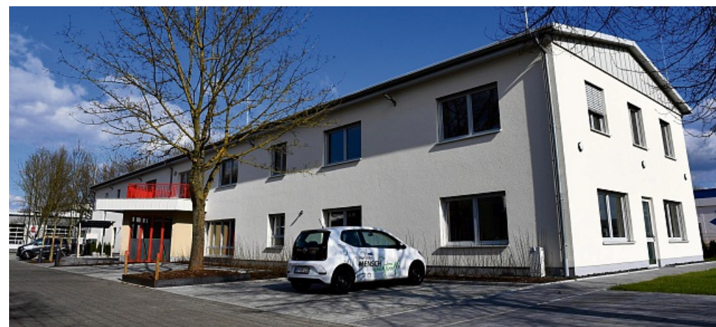
Das neue „Stellwerk“ der Sozialen Förderstätten in Bebra.
