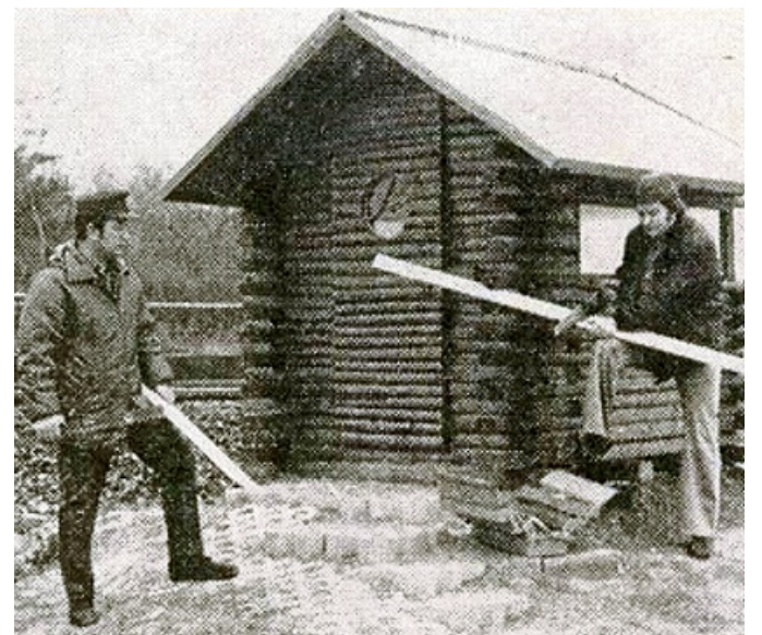
Das war einmal: Am Ende des Schwarzen Weges in Obersuhl steht an der Bahnlinie zwischen Bebra und Eisenach eine Schutzhütte. Zwei Zollbeamte nehmen letzte Baumaßnahmen vor.
