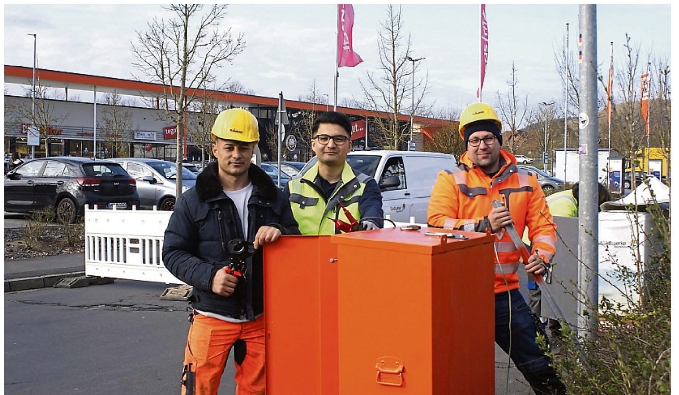
Vorarbeiten: Unser Bild zeigt Yasin Ozbek (Firma Räuber), Abbas Siasi (Stadtwerke) und Christopher Gimpel (Räuber), die am Dienstmorgen unter anderem für den Stromanschluss auf der Baustelle sorgten. FOTO: NADINE MEIER-MAAZ
