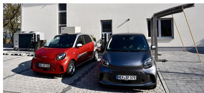
Die Ladesäulen versorgen E-Autos mit Strom
