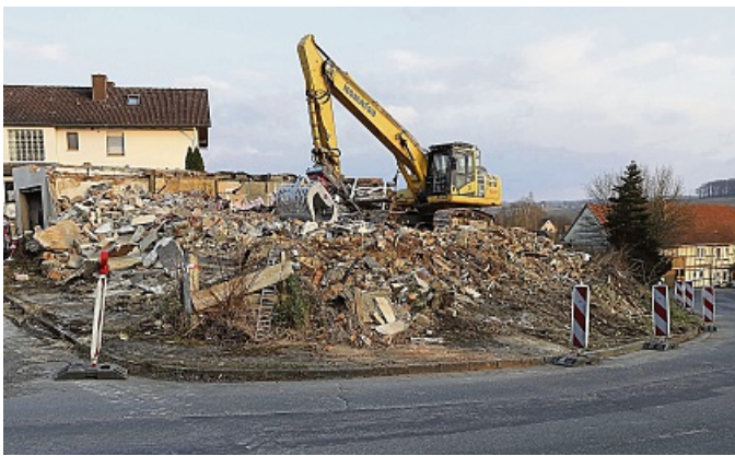
Trendelburg-Gottsbüren: Das Brandhaus die Brandruine Wohnhaus am Rusteberg wird abgebrochen.
