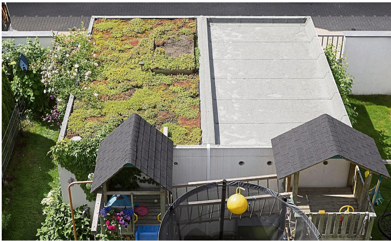
Vor der Begrünung sollte die Statik und die Neigung des Dachs überprüft werden.
