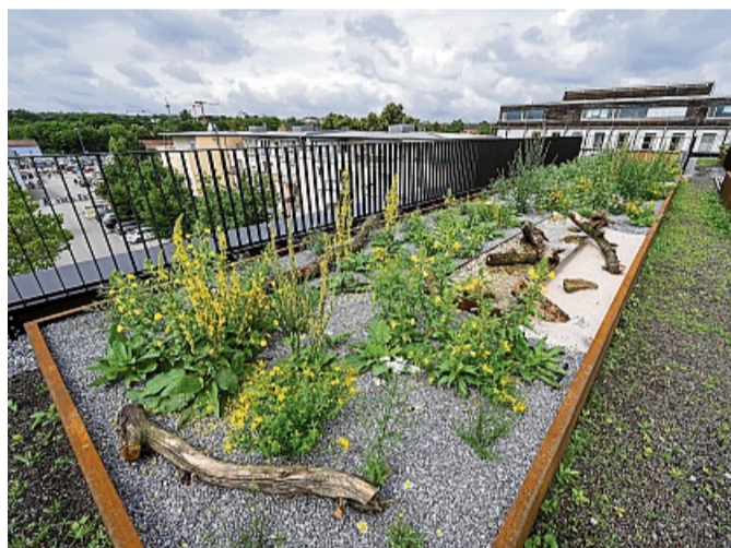
Eine Dachbegrünung muss genau geplant werden – nicht für jedes Dach eignet sich jede Art von Bepflanzung.
