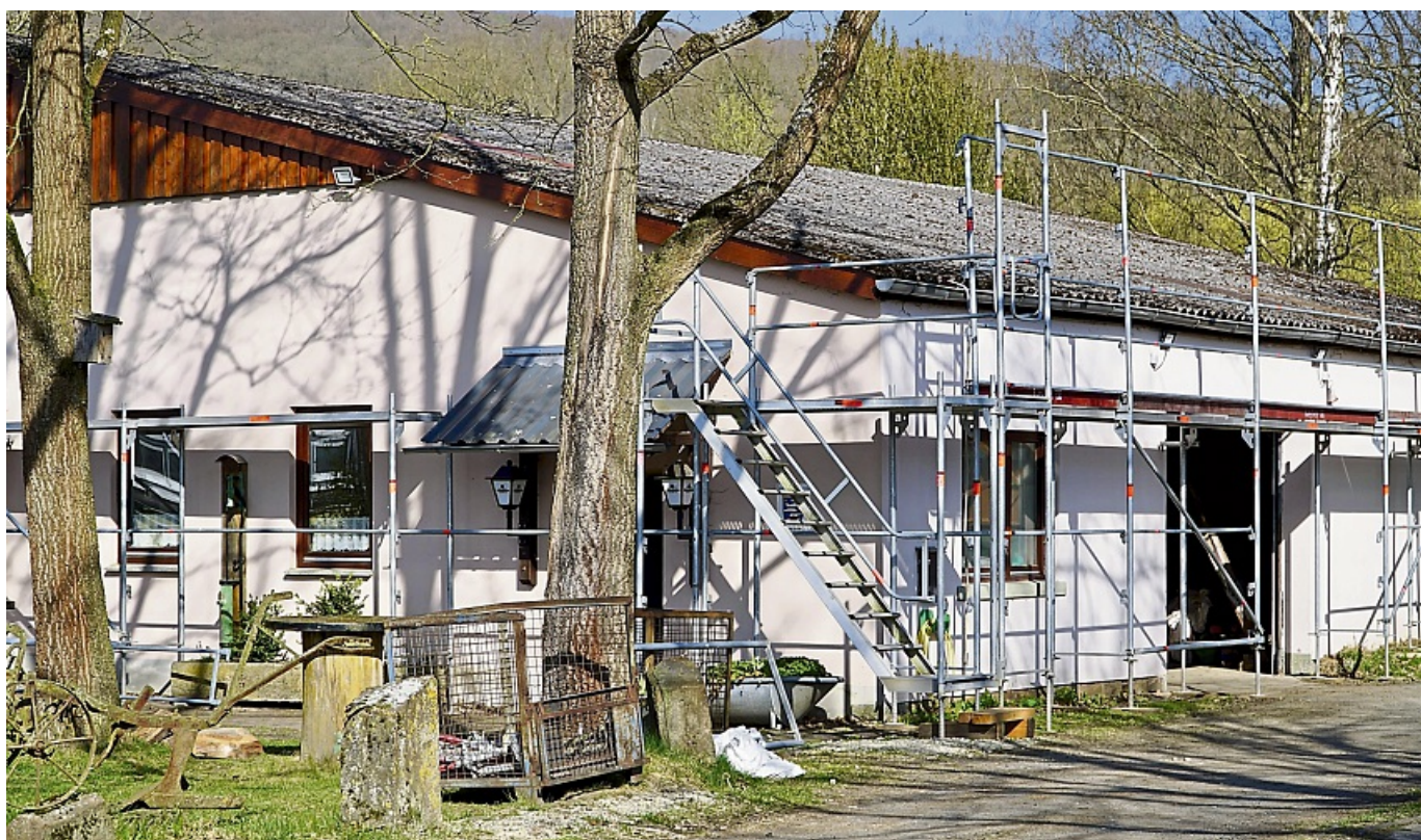
Bekommt ein neues Dach: Die Heimatscheune in Vernawahlshausen.
