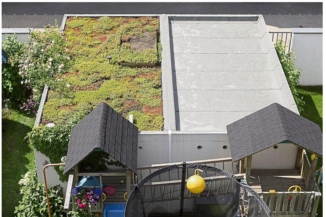
Vor der Begrünung sollte die Statik und die Neigung des Dachs überprüft werden.
