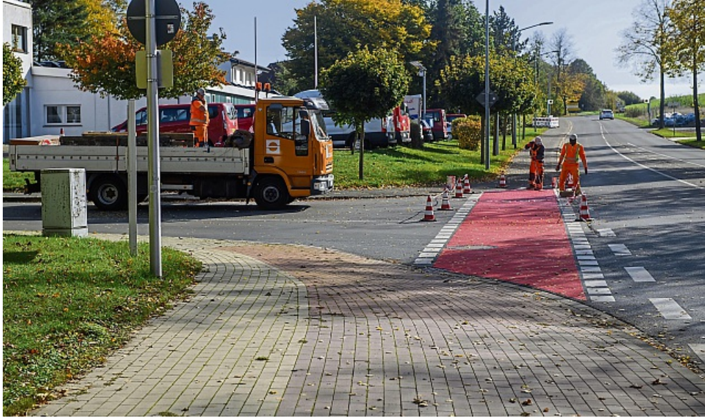
Rote Radwege an der Kurfürstenstraße: Die farblich abgesetzten Streifen erhöhen die Sicherheit für Radfahrer auf der stark befahrenen Straße. ARCHIVBILD: PAUL BRÖKER
