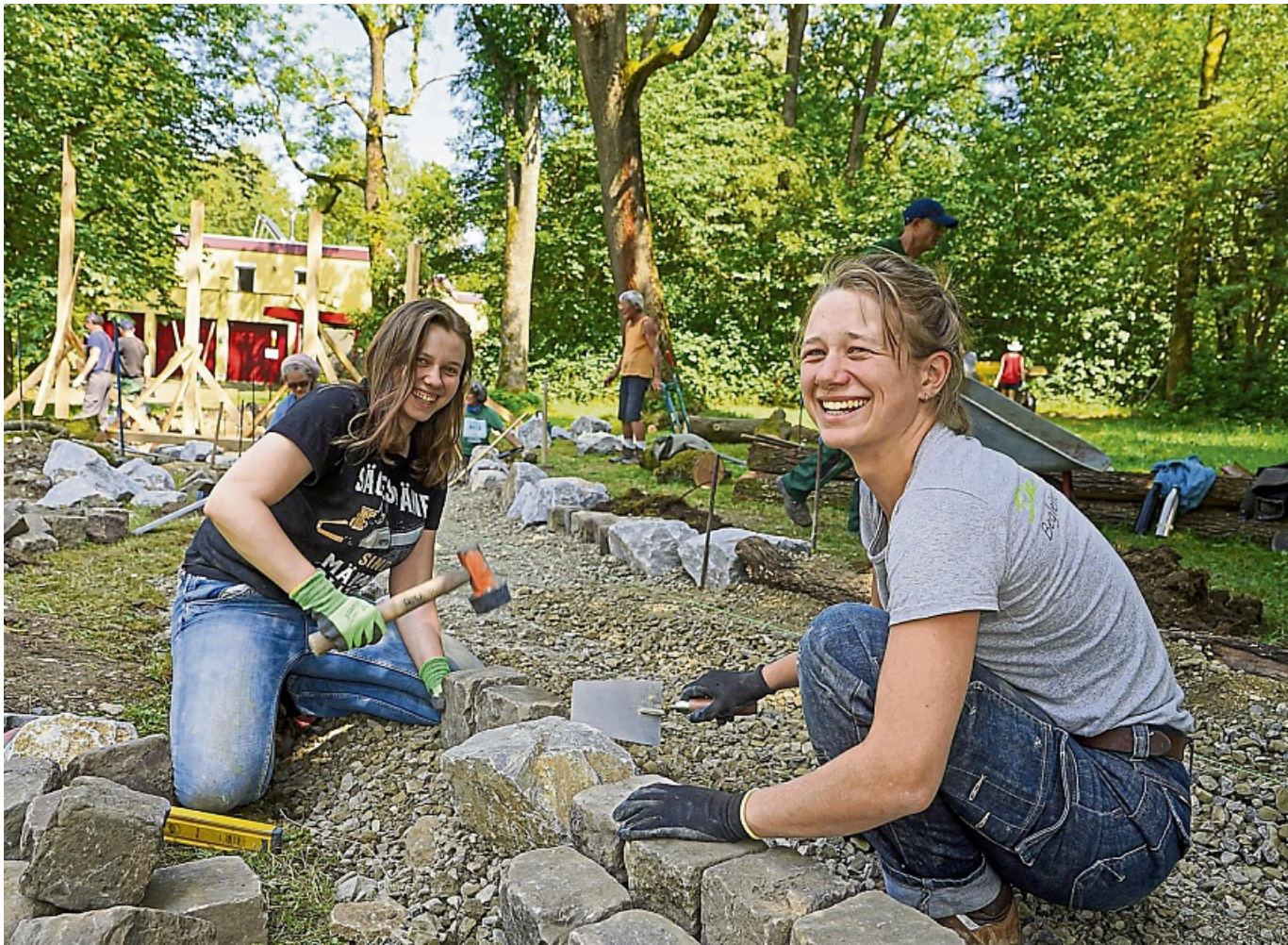
Arbeiteten im vergangenen Jahr am neuen Regenwasserlauf mit, der heute bereits das Gelände mit Wasser versorgt: Johanna Altgaßen (links) und Anna Überschär.
