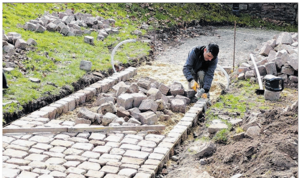
Die Pflasterarbeiten wurden ehrenamtlich ausgeführt. Foto: Detlef Schieweck
