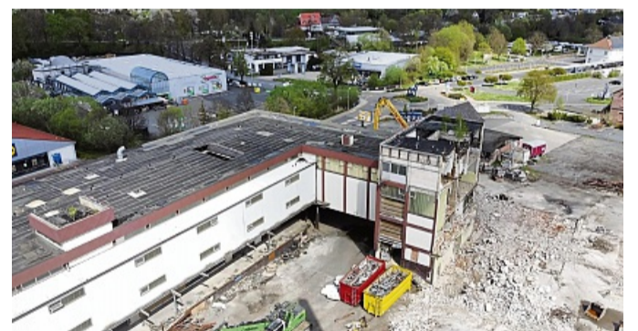
Die Abrissarbeiten an der alten Molkerei machen Fortschritte, ist aus der Vogelperspektive zu erkennen. FOTO: D+S BAUSTOFF RECYCLING/PR
