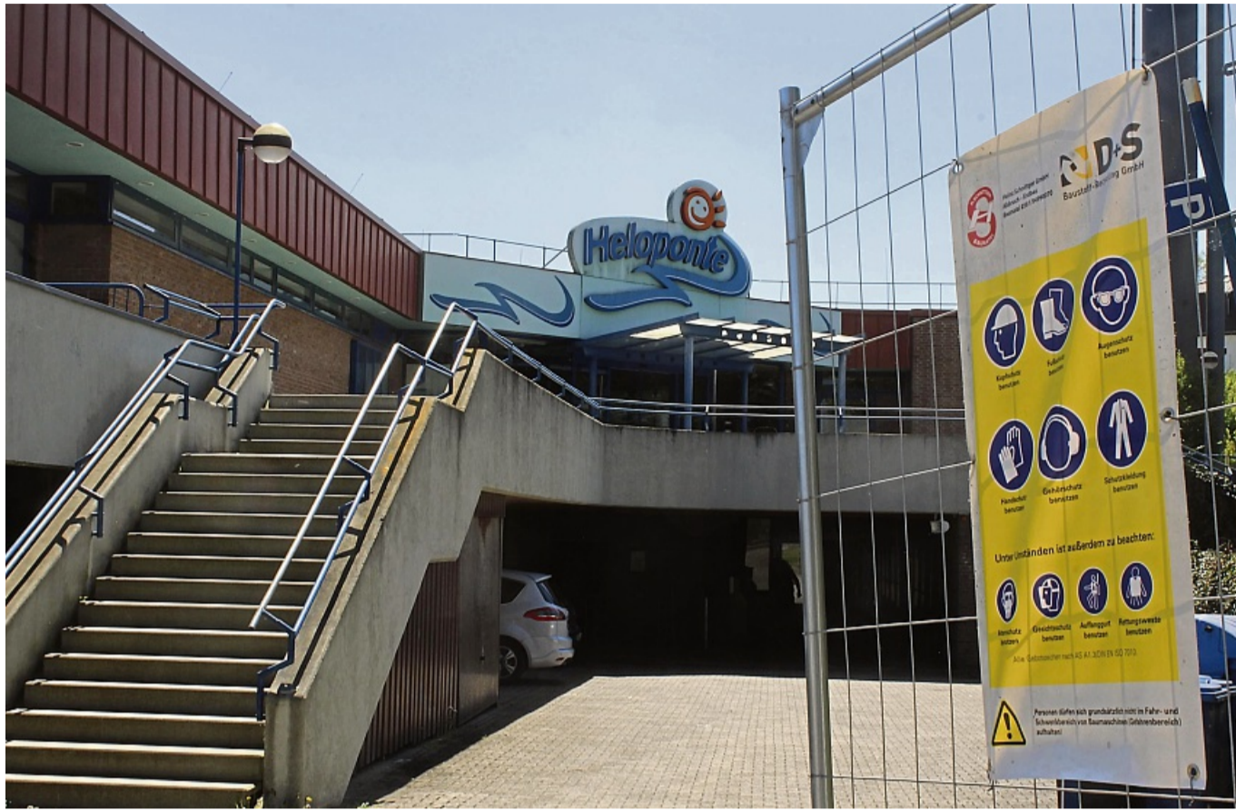
Der Bauzaun mit Warnhinweisen zur Schutzausrüstung während des Abrisses ist installiert. Seit Montag läuft der Abriss des Heloponte in Form der Vorarbeiten im Inneren. FOTO: SCHULDIT
