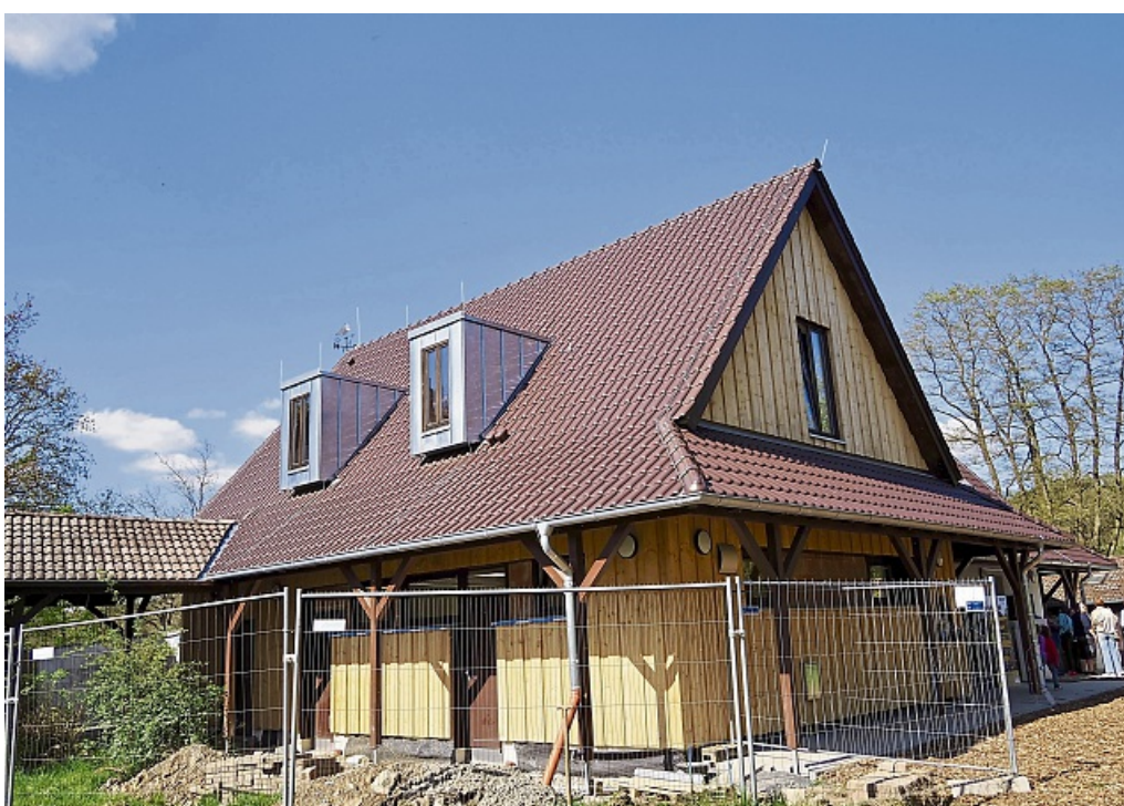
Das neue Küchenhaus: Hier muss noch ein altes Betonfundament entfernt werden, bevor gepflastert werden kann. FOTO: DOROTHEE KÖNEMANN
