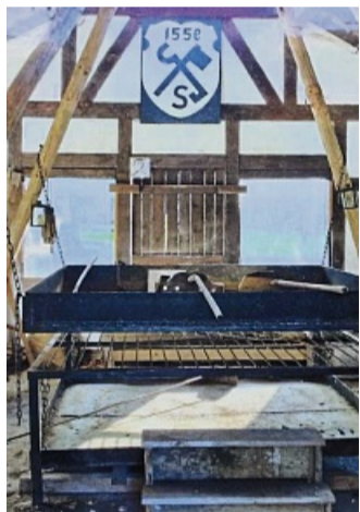
Das Siedekot vor der Sanierung: Es diente lediglich als Ausstellungsgebäude.
