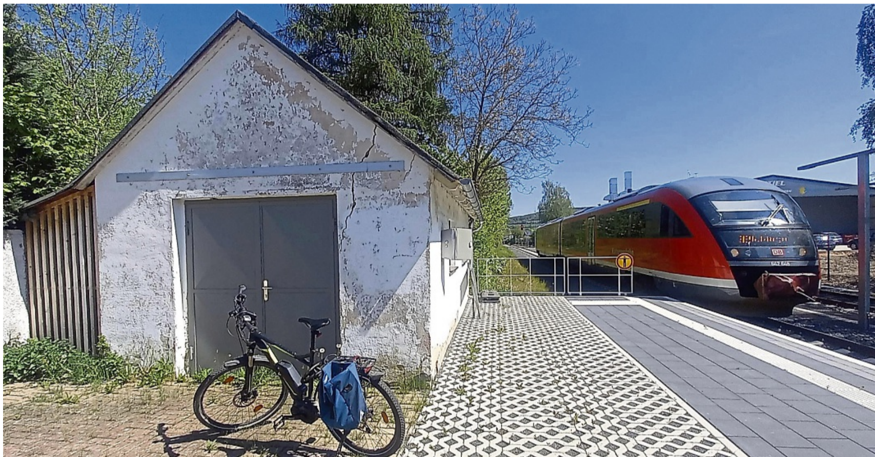
Eines von mehreren Projekten: Dieses Gebäude am Bahnhof wird zu einer Fahrradgarage umgebaut. Die Plätze lassen sich künftig beim Nordhessischen Verkehrsverbund buchen. FOTO: SCHULTZ
