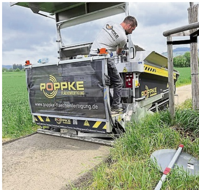
Um Straßen und Wege schnell und effizient anlegen zu können, nutzt André Poppke eigene Pflastermaschinen sowie einen Flächenfertiger. FOTOS: PRIVAT / REPOS: GITTA HOFFMANN
