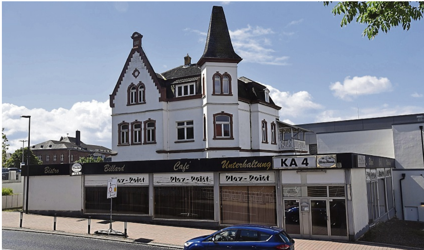
Die Villa an der Kasseler Straße hatte Schoofs 2020 gekauft. Das Spielkasino sollte eigentlich abgerissen werden.
