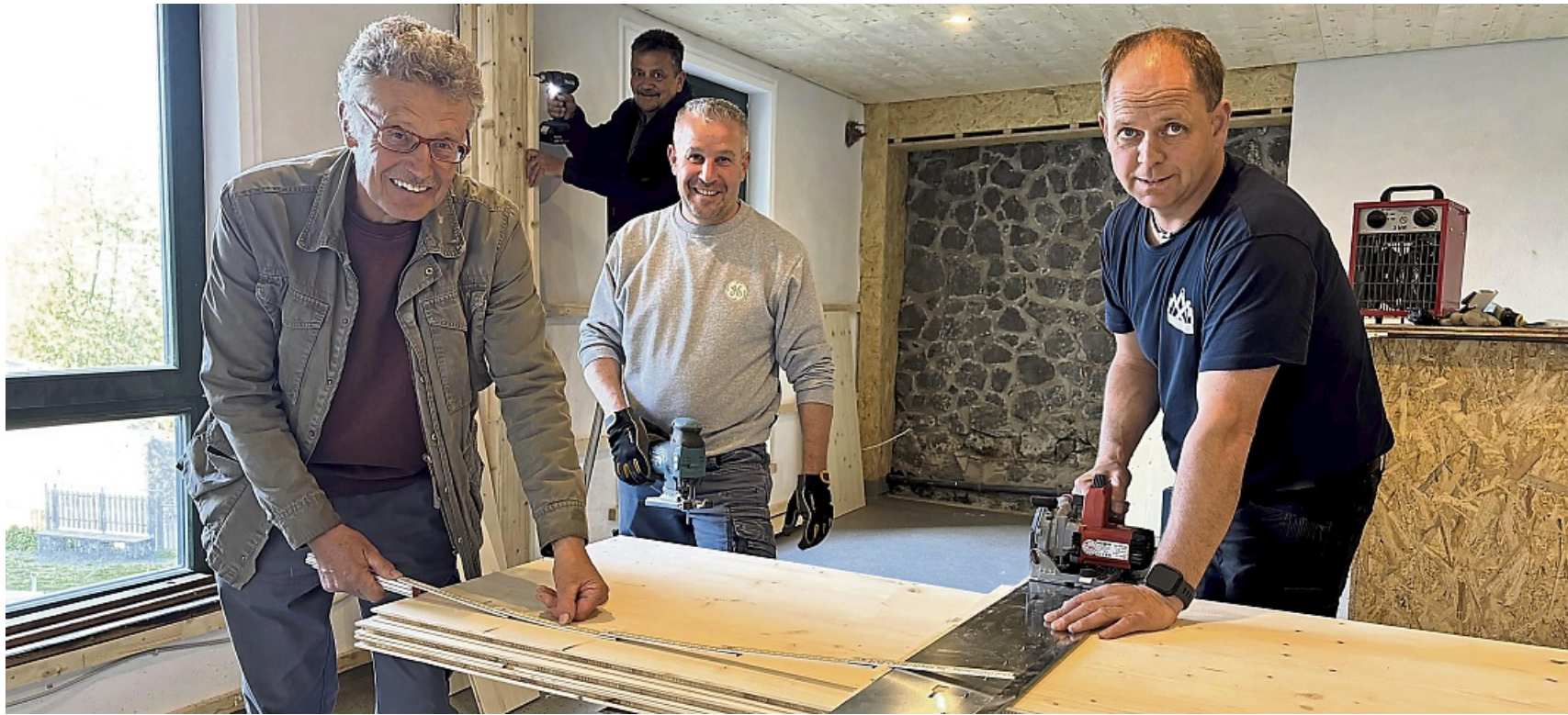
Arbeiten an der Baude: Am 15. Juni startet das Bauden-Team des Fördervereins zur Erhaltung der Weidelsburg in die Saison. Dann werden auch die letzten Arbeiten im Gastraum erledigt sein. Rolf Klapp (von links), Tim Nolte und Marco Seumer sowie im Hintergrund Matthias Thielemann verkleiden Teile der Wände mit Holz.
