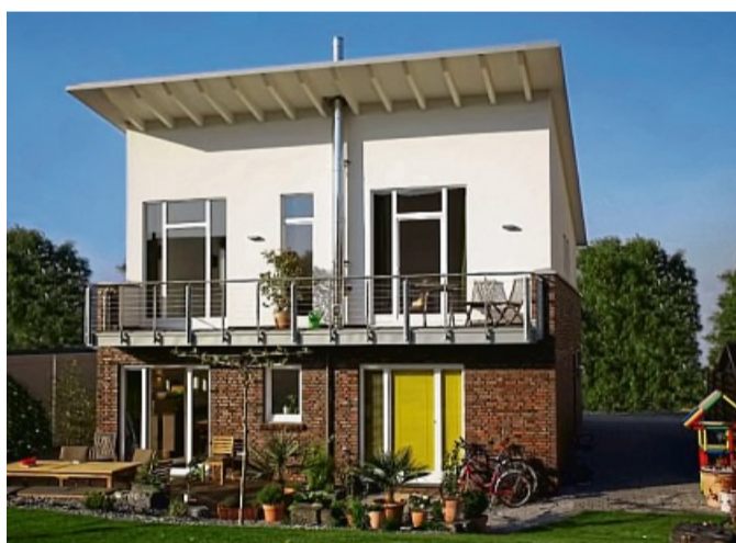
Im Gebäudebestand lässt sich ein Edelstahlschornstein wirtschaftlich und effizient nachrüsten.
