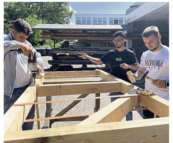
Fachwerkwände an der BBS Münden: Andi Shala, Haradin Qusm und Erald Haxhia bei der Arbeit. Der Förderverein Mündener Altstadt e.V. hatte das Projekt angestoßen.
