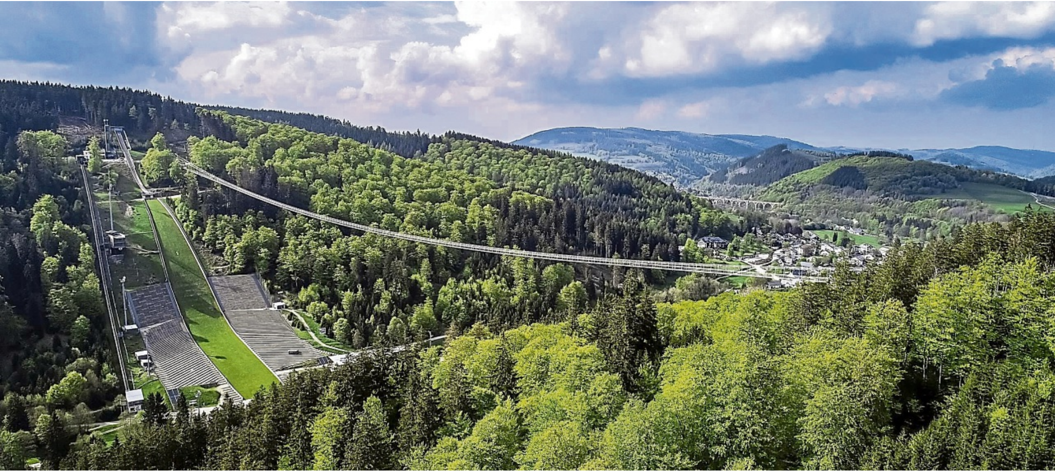
Zieht viele Besucher an: Der Skywalk in Willingen. Die längste Fußgänger-Hängebrücke Deutschlands, die sich vom Mühlenkopf bis zum Musenberg erstreckt, wurde im Sommer 2023 eröffnet. FOTO: PR
