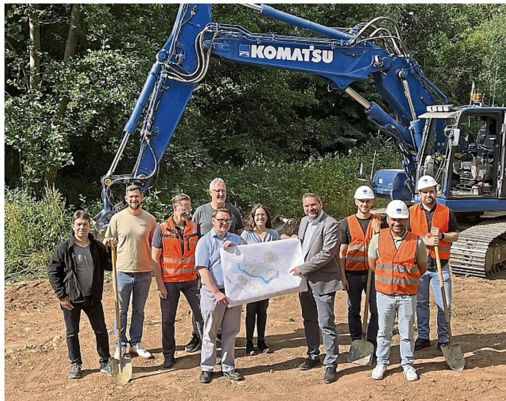
Baubeginn für den 2. Bauabschnitt bei der Renaturierung der Thiele-Aue. Mit Bürgermeister Marko Lambion, Marko Tröger vom Bauamt, Planerin Katharina Janus vom Büro GTL Landschaftsarchitekten, Kassel, Vertreter vom Ingenieurbüro Oppermann in Vellmar und Mitarbeitern der Baufirma Herrmann..
