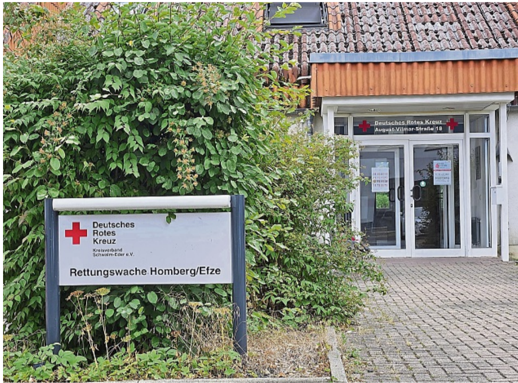
Soll erneuert und vergrößert werden: Die Umbauten an der Rettungswache in Homberg sollen im kommenden Jahr starten. FOTO: CHANTAL MÜLLER
