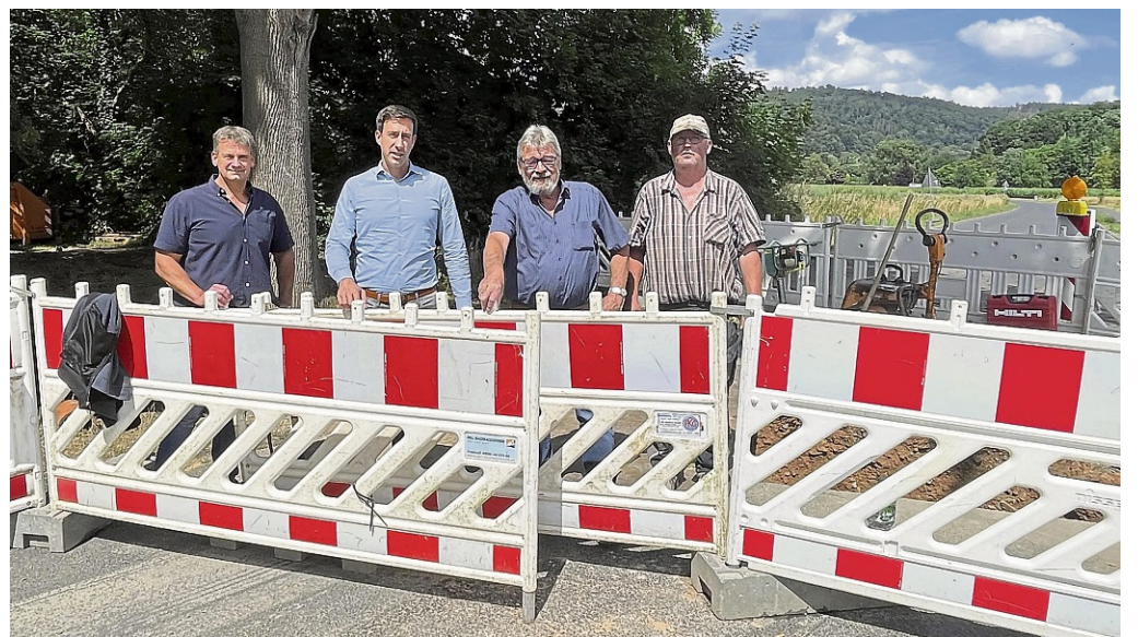
An der Baustelle am Thielebach: Joachim Spiegler, Leiter des städtischen Eigenbetriebs Stadtentwässerung, Bürgermeister Tobias Dannenberg, Gintes Ortsbürgermeister Peter Katzwinkel und Heiner Faulwasser, Mitarbeiter Firma Kirchner (v.li).
