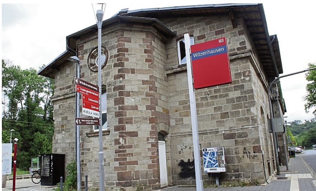
Nordbahnhof in Witzenhausen: Das Empfangsgebäude ist dicht.
