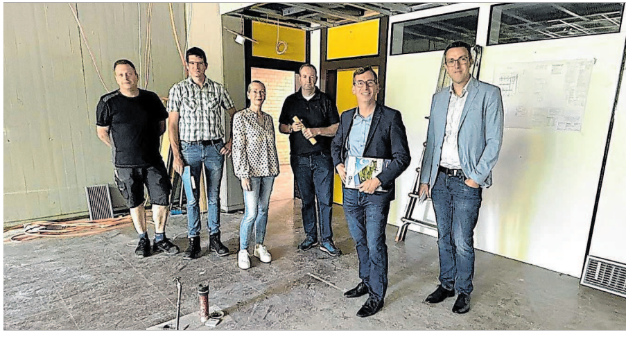
Hier entsteht der neue Physikraum des Hüffertgymnasiums: Hausmeister Christoph Menne (von links), Florian Stieneke (Fachbereich Bauen und Stadtentwicklung), Schulleiterin Susanne Krekeler, Ulrich Klare (Leitung Fachbereich Bauen und Stadtentwicklung), Bürgermeister Tobias Scherf und der erste Beigeordnete Andreas Niggemeyer überzeugten sich vom Verlauf der Baumaßnahmen.
